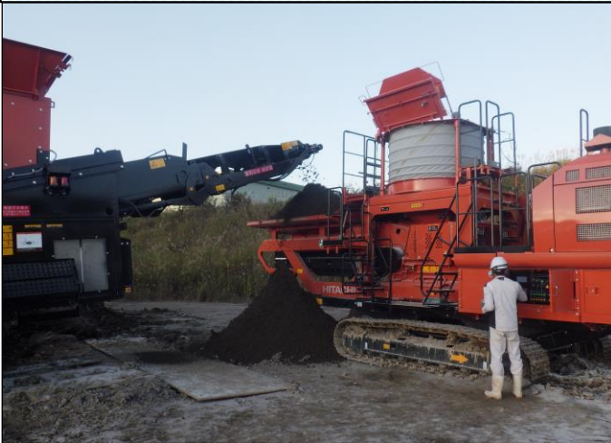
改良土の仮締固め・整形(改良直後)
