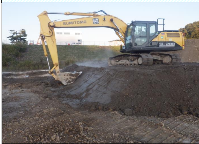
改良土敷き均し・締固め(堤防)
