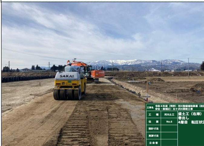
改良土敷き均し・締固め(堤防)
