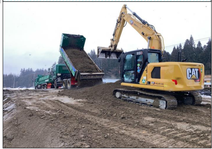
築堤盛土 施工状況
