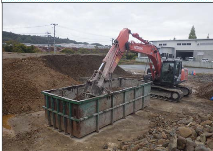
補強土壁背面への改良土投入
