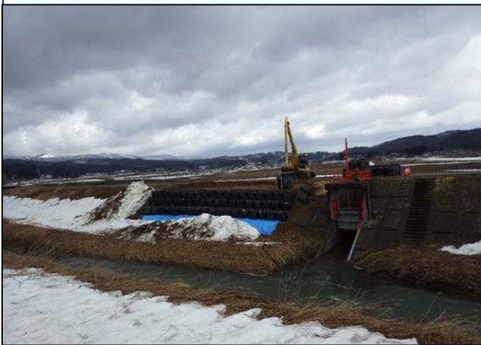
仮設クレーンヤード完成 (敷き鉄板設置)
