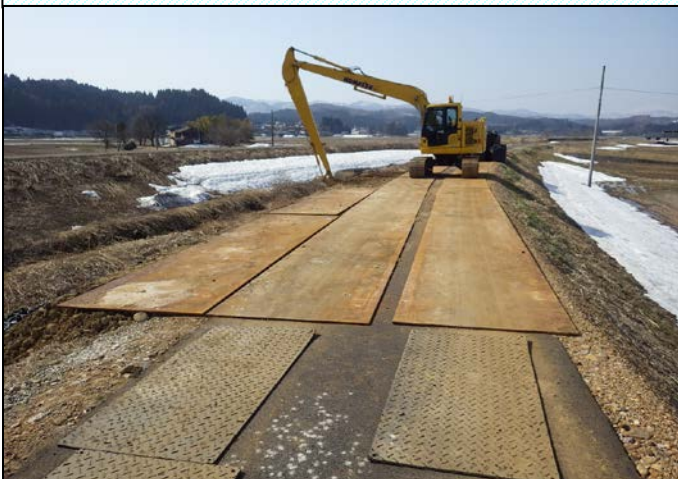
仮設クレーンヤード完成 (敷き鉄板設置)
