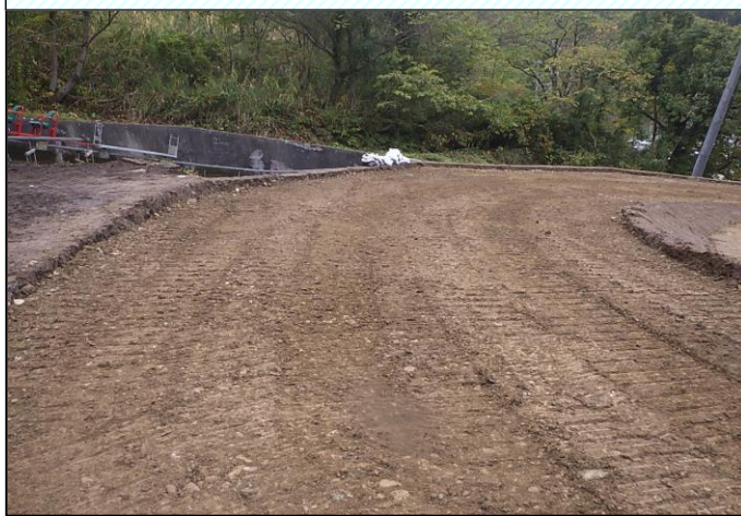
工事用道路(路床部)完成
