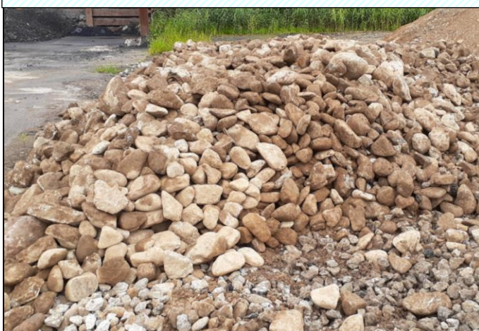
一次分級後 \phi 150\text{mm} オーバーは「かご石」利用へ
