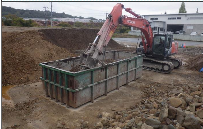
一次分級後 \phi 150\text{mm} アンダーは生石灰改良し路床土利用へ
