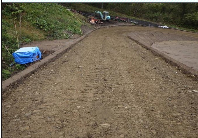
工事用道路(路床部)完成
