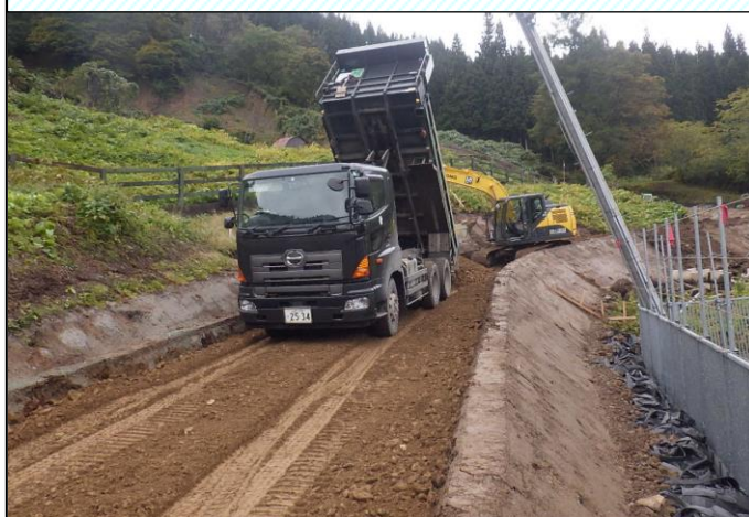
工事用道路へ改良土(路床材)投入
